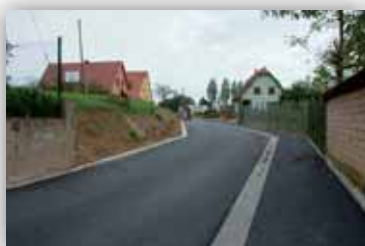
Rue Froehn à Scharrachbergheim, achèvement des travaux en octobre 2007
